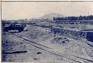
Detalle de las cimentaciones
